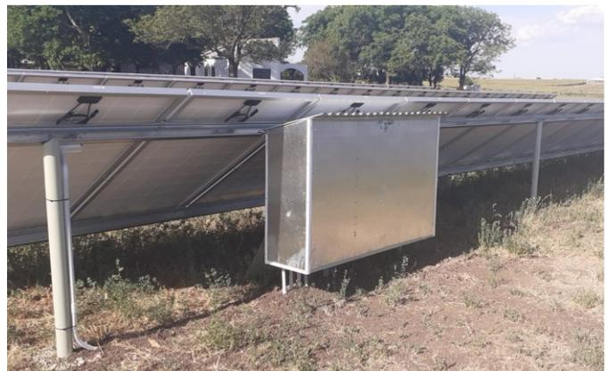
Fig. 10. Estructura de soporte de los paneles y gabinete del inversor.
