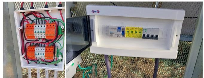
Fig. 9. Tablero de protección de CC (izquierda) y AC (derecha)..
