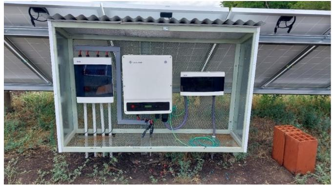
Fig. 8. Gabinete del inversor y de los tableros de protección.
