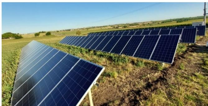
Fig. 7. Disposición de los cuatro strings de paneles.
