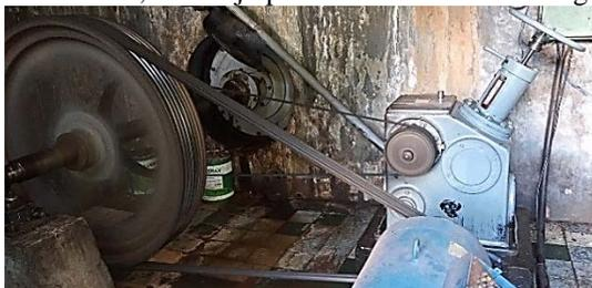
Fig. 2. Arranjo do gerador acoplado por correias ao eixo da turbina hidráulica.
